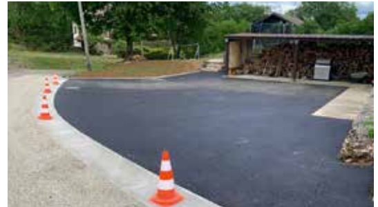
Cour en enrobé
