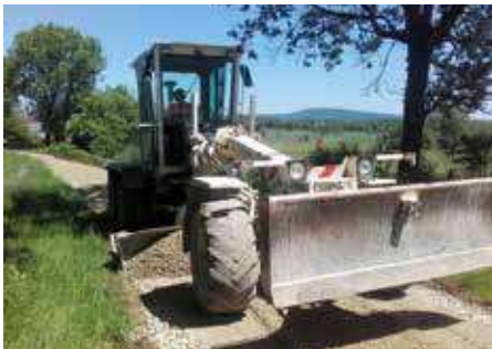
Travaux sur voirie
