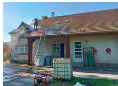
et lichens des tuiles, s'infiltrait en sous-toiture. Il fallait intervenir avant dégradations majeures. Travail périlleux en hauteur, avec lances à pression, vêtements spécifiques étanches et harnais de sécurité câblés de rigueur.
