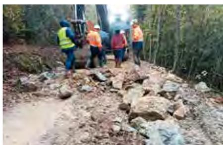
réservoirs. Un renforcement sur la longueur totale de ce chemin d'une quarantaine de centimètres de hauteur, est réalisé avec les matériaux calcaires extraits du site. Apport, nivellement, concassage, enrochement, font de ce chemin une voirie digne de ce nom.
