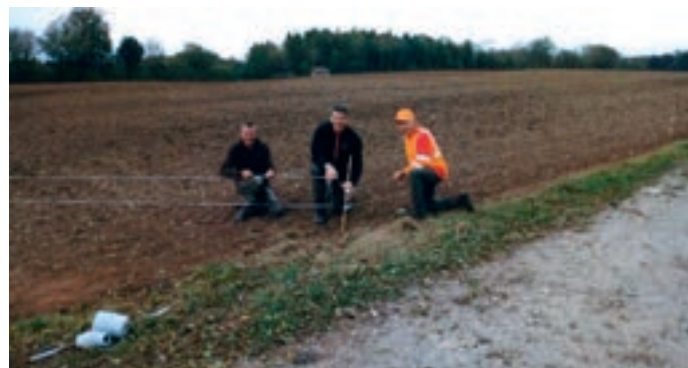
Pose de clôtures
